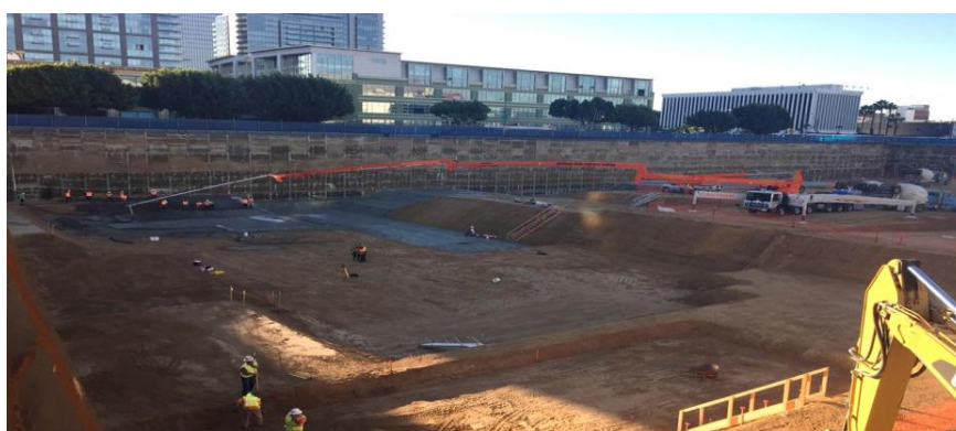
洛杉矶泛海广场施工现场
